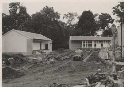
10-Conjunto de Mo- radia e Posto Sanitário.
